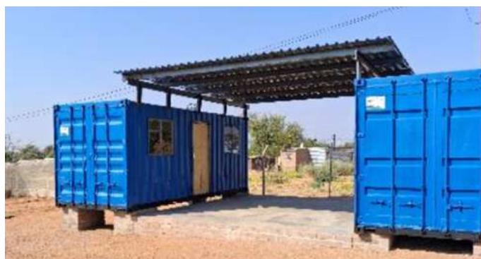
Contenedores donados a dos de los centros de mayores para su uso como almacenes, lugar de reuniones, cocinas, etc.
