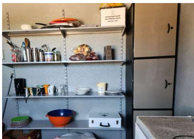
Nuevos armarios y estanterías para instalados en la cocina escolar
